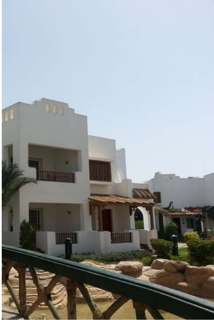
اسم الصورة: بساطة الأبيض اسم المبنى: دلتا شرم الشيخ
