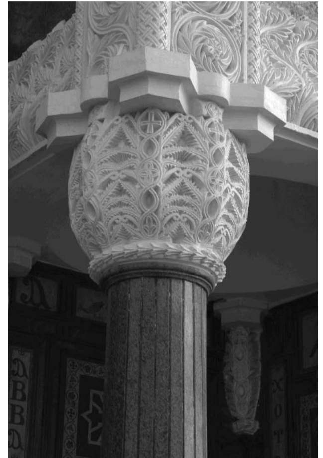
Le nouveau monastère est construit de marbre d'Italie et du granite rose d'Assouan.
