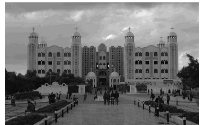
La basilique moderne construite à quelques centaines de mètres de l'ancien site de Saint Méнас
