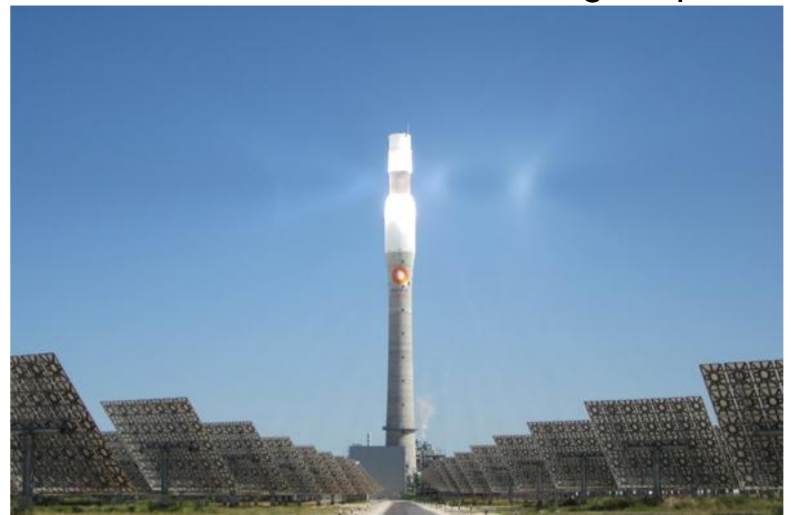
Gemasolar: 20 MW 15 h storage, Spain
