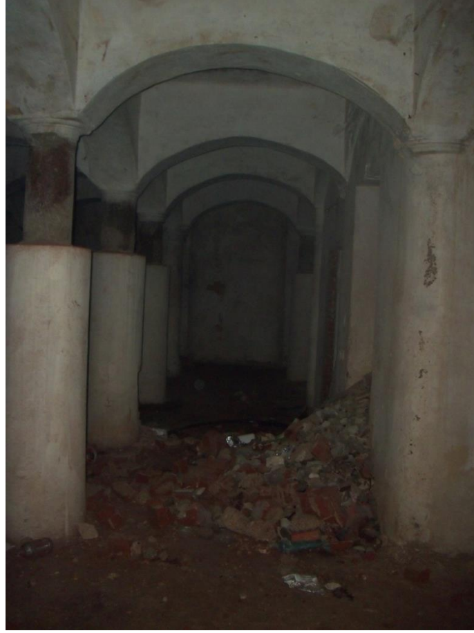
شكل (٢-١٢): صورة للصهريج والأضرار التي تسبب فيها المبنى الذي تم تشييده حديثاً (المصدر: الباحثون)
